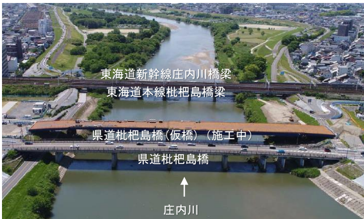
県道枇杷島橋架替工事施工状況 (R4.5撮影)
