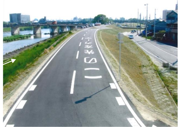
築堤状況 (右岸県道枇杷島橋上流)
