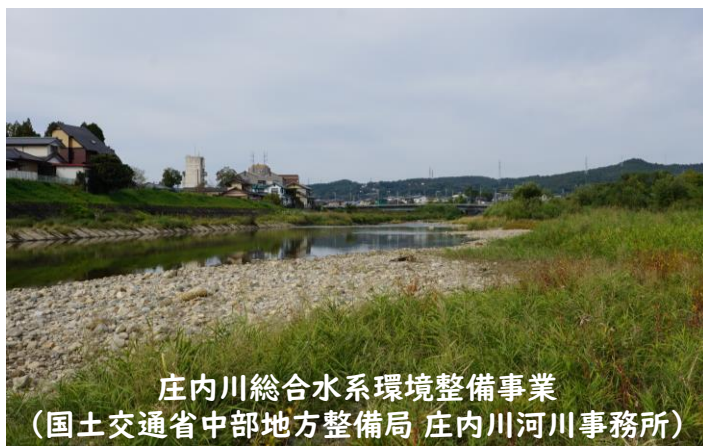
写真：土岐市三共橋下流付近より下流側を臨む
